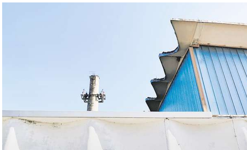
Problemfall: die Turnhalle in Flecken Zechlin.
